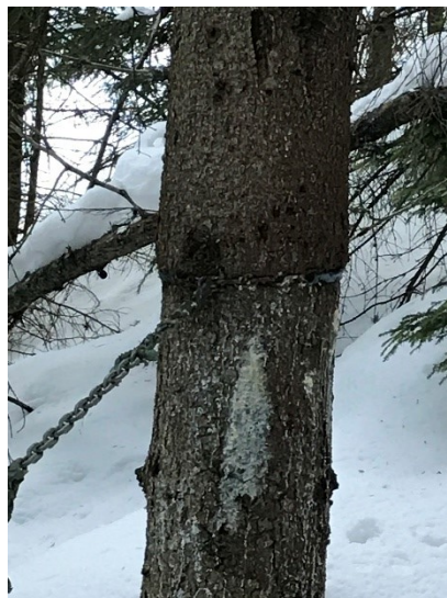
Inngroing av bardunering i tre (1.08.087)
