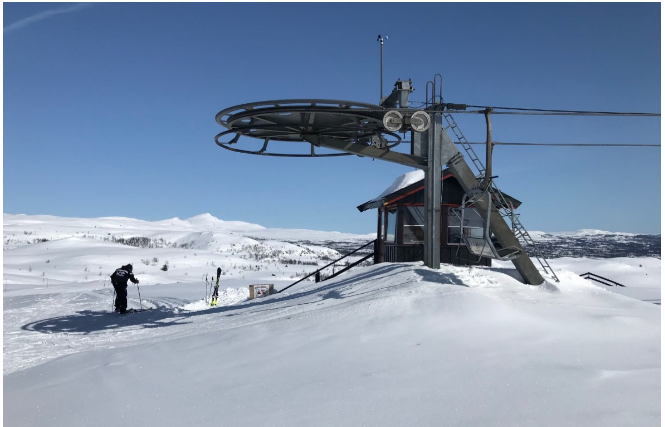
Bilde: Avstigningen på Sørre Knausen sett fra siden. Ut fra bildet kan det se ut som om avstigningsområdet har en stigning frem mot nedkjøringsrampe. Dette ble ikke målt ved tilsynet.
