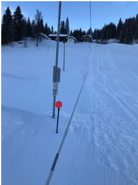
Avstand mellom trekktau og mast ved påstigning.
