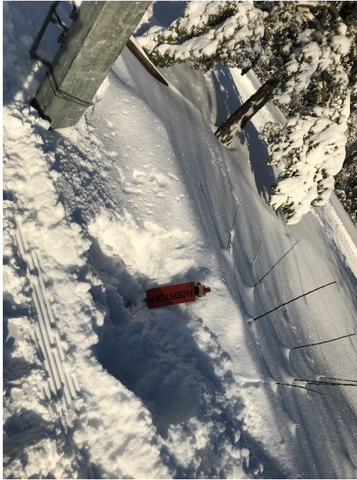
Plassering av nødstopbryter på avstigning
