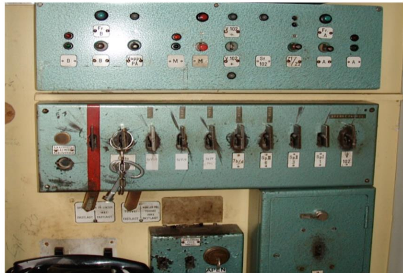
Sikringsanlegg i bruk ved Hønefoss
