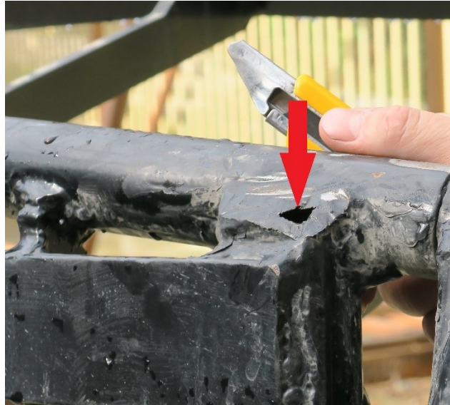
Hull i sveis på skinne i berg- og dalbanen.
